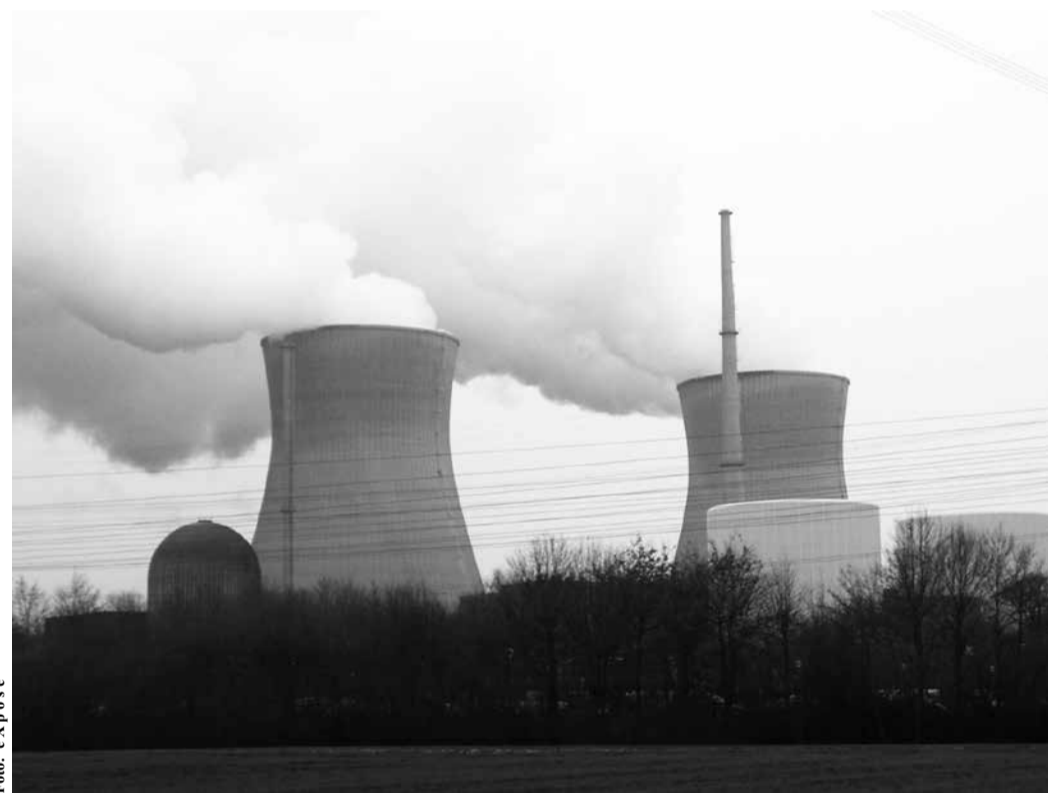
Das Atomkraftwerk Gundremmingen
